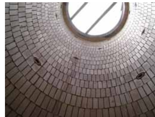
メンテナンス・内部検査
